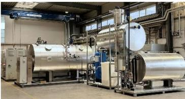
ECOTHERM hat erfolgreich das erste Großprojekt in Griechenland abgeschlossen. In Thessaloniki wurde in der neuen EPS-Produktion (Polystyrol) der Firma ISOMAT eine ECOTHERM-Anlage errichtet. Der elektrische Dampfkessel mit einer Kapazität von 3.200 kg/h und einem Druck von 10 bar ist nun betriebsbereit und wird zu Gänze durch PV-Strom betrieben.
